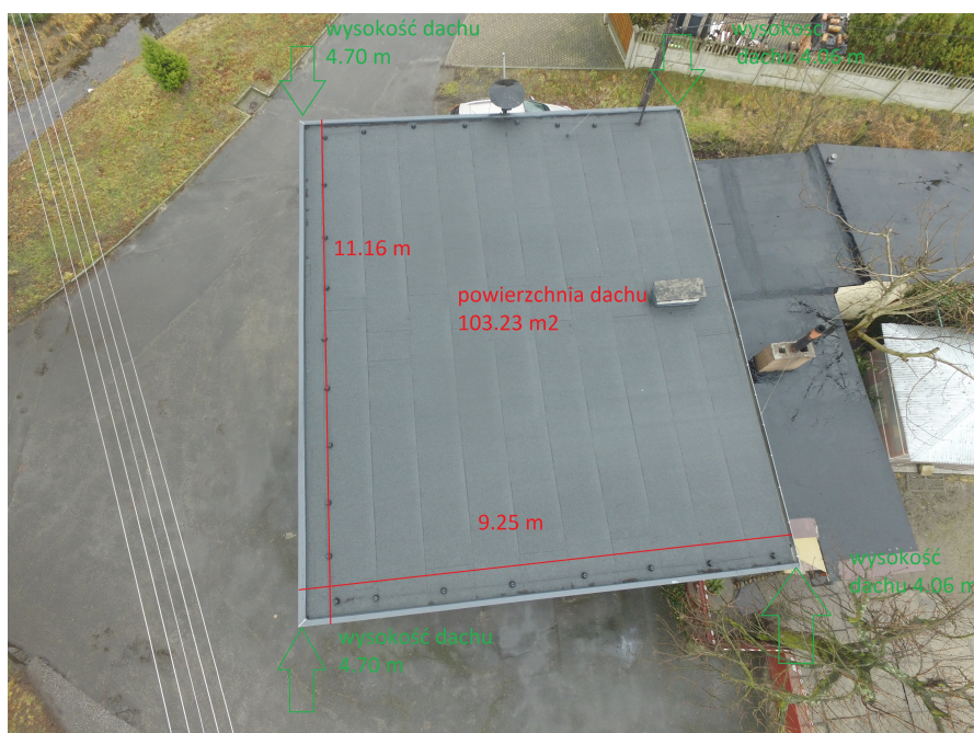
Zdjęcie 2. Stan obecny pokrycia dachowego – wymiary dachu
